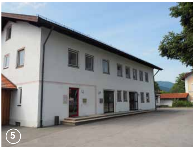
5 Feuerwehrhaus mit Vorplatz
