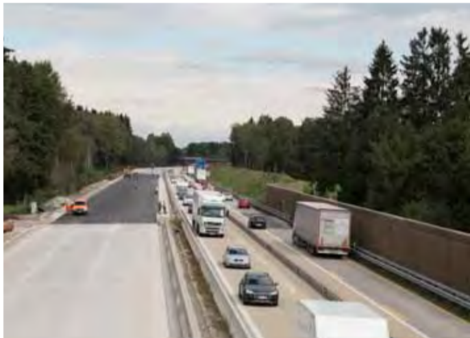
Ausbau Autobahn A93
