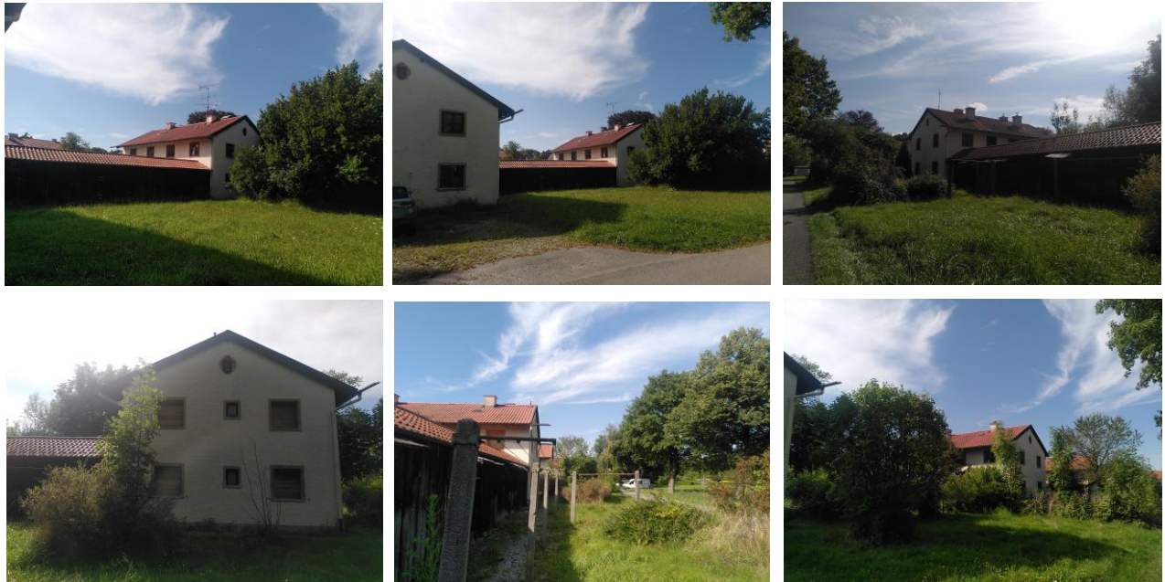
Abbildung 8: Nordost- und Ostseite des Plangebietes mit Gebäuden, Schuppen und Vegetation in der Gemeinde Raubling, LKr. Rosenheim (Mühl 26.08.2025)
