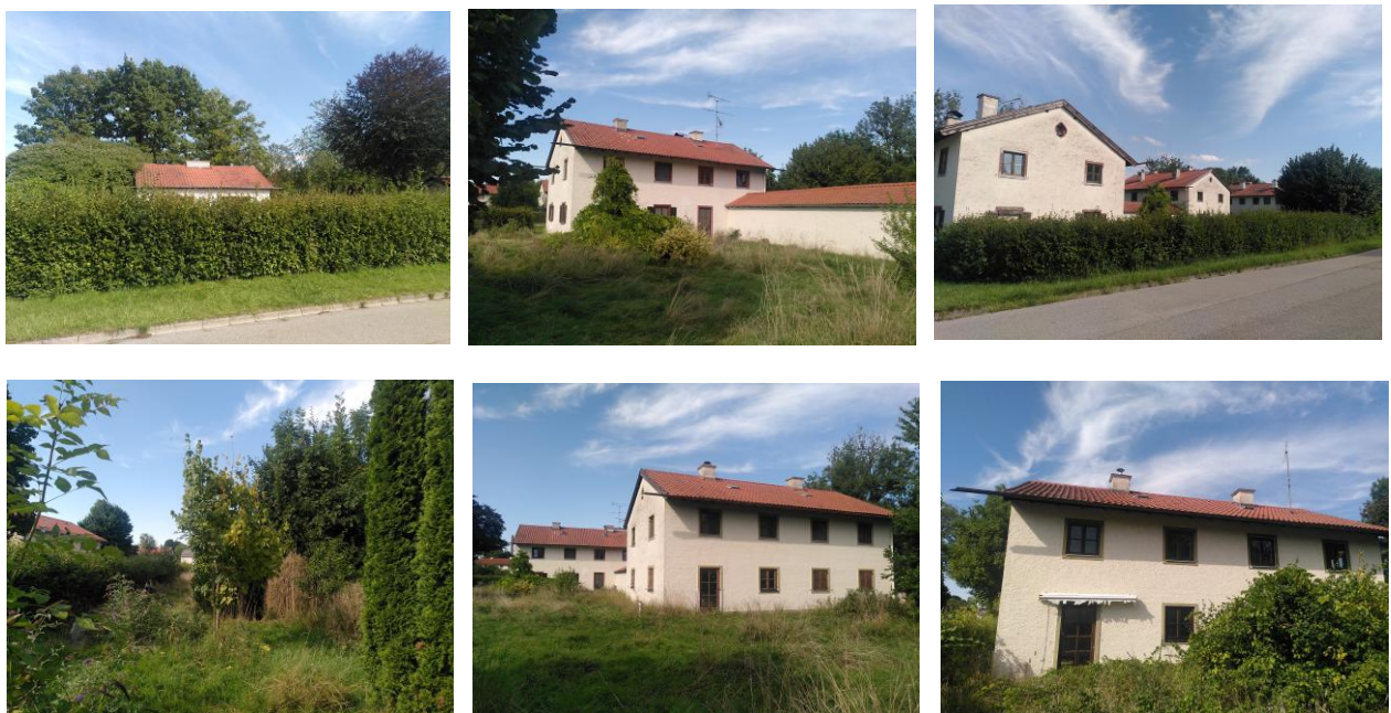
Abbildung 9: Westseite des Plangebietes mit Gebäuden, Vegetation in der Gemeinde Raubling, LKr. Rosenheim (Mühl 26.08.2025)
