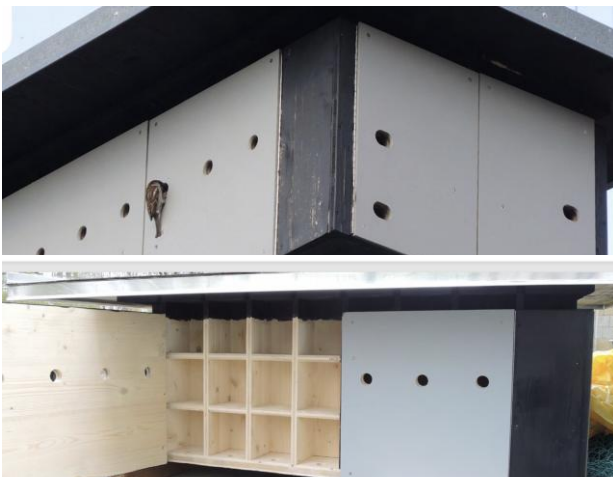
Abbildung 7: Spatzenturm mit Innenansicht (LBV 2025)
